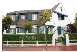
Villa " Bic en Coin " - 1925 (Architecte : Louis Quételart) 8 rue Joseph Duboc
