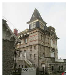
Villas " Saint-Augustin, Thalassa, Phébus, Borée " - 1897 (Architecte : L Casiorowski) Boulevard Jules Pouget angle Rue de la Paix Arrêté d'inscription du 18 décembre 1998 - Sont inscrites les façades et les toitures. Cet ensemble architectural présente un intérêt suffisant pour en rendre désirable la préservation en raison de l'exemple unique d'une grande demeure familiale de la fin du XIX ème siècle en front de mer.
