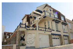
Villa " Le Quart d'Heure " - 1925 (Architecte : Horace Pouillet) 3 rue Saint-Amand
