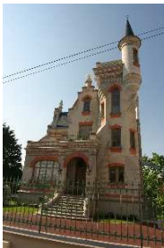
Villa " Le Castel " - 1904 (Architecte : Henri Valette) 50 rue Jean Monnet
